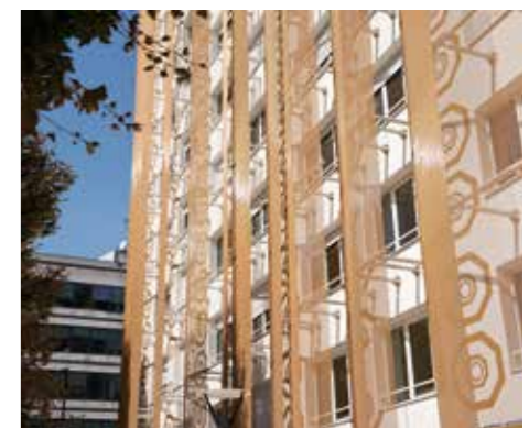
Metallic coating. Résidence Étudiante, Saint Denis, France.
